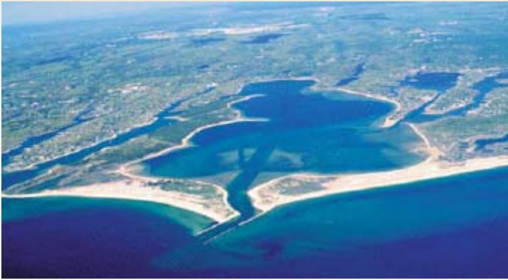
Pirsy. Pirsy są budowane, żeby ochronić, bądź umocnić wejście do przystani
